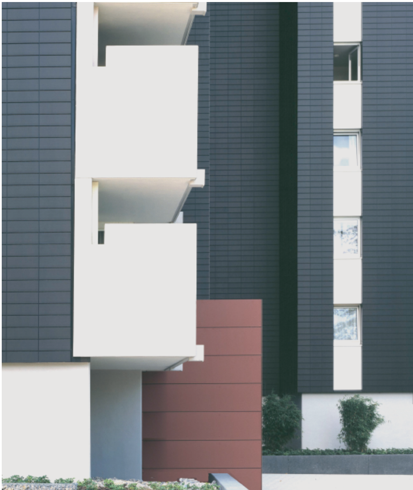
Objekt: Fassadensanierung Pforzheim Architekt: SWS Strolz Weisenburger Scheidel Architekten BDA, Karlsruhe Produkt: Eternit Fassadenziegel Tonality Classic, oberflächenveredelt, anthrazit Foto: Dirk Altenkirch, Karlsruhe
