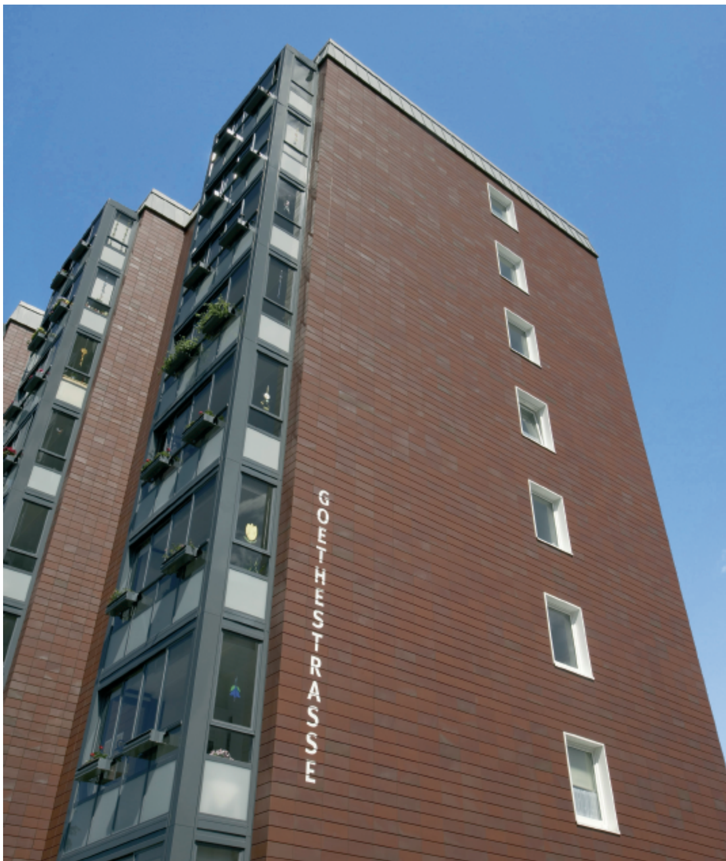
Objekt: Fassadensanierung Bremerhaven Bauherr: Wohnungsgenossenschaft Bremerhaven eG Produkt: Eternit Fassadenziegel Tonality Classic, Sonderserie Blaubunt Foto: Jochen Stüber, Hamburg
